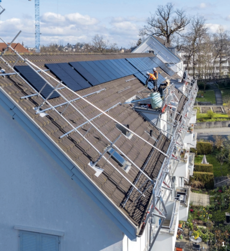
1 Giebelseitiger Seitenschutz und Dachfangwand an der Dachtraufe als Kollektivschutz. 2 Mitlaufendes Auffanggerät mit Kernmantelseil an einer permanenten Anschlageinrichtung. 3 Giebelseitiger Seitenschutz als Kollektivschutz bei der Montage der Solaranlage.
