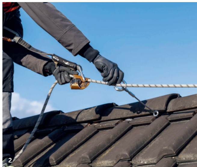
1 Giebelseitiger Seitenschutz und Dachfangwand an der Dachtraufe als Kollektivschutz. 2 Mitlaufendes Auffanggerät mit Kernmantelseil an einer permanenten Anschlageinrichtung. 3 Giebelseitiger Seitenschutz als Kollektivschutz bei der Montage der Solaranlage.
